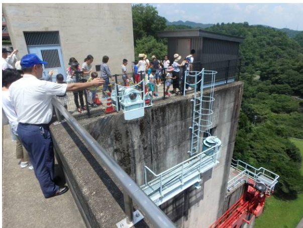
ダム天端から洪水吐を見学(室生ダム)
